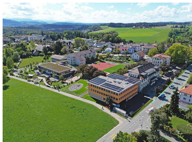
Schulareal Zentral – mit Erweiterungsbau (unten rechts), dank GFL-Anträgen im Minergie-P-Standard mit Solarstrom-Panels auf dem Dach
